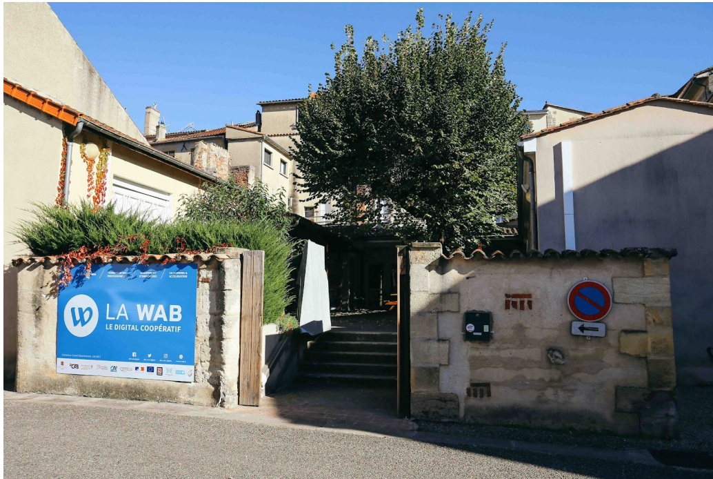
Entrée sur parking, rampe handicapé à gauche de l'escalier
